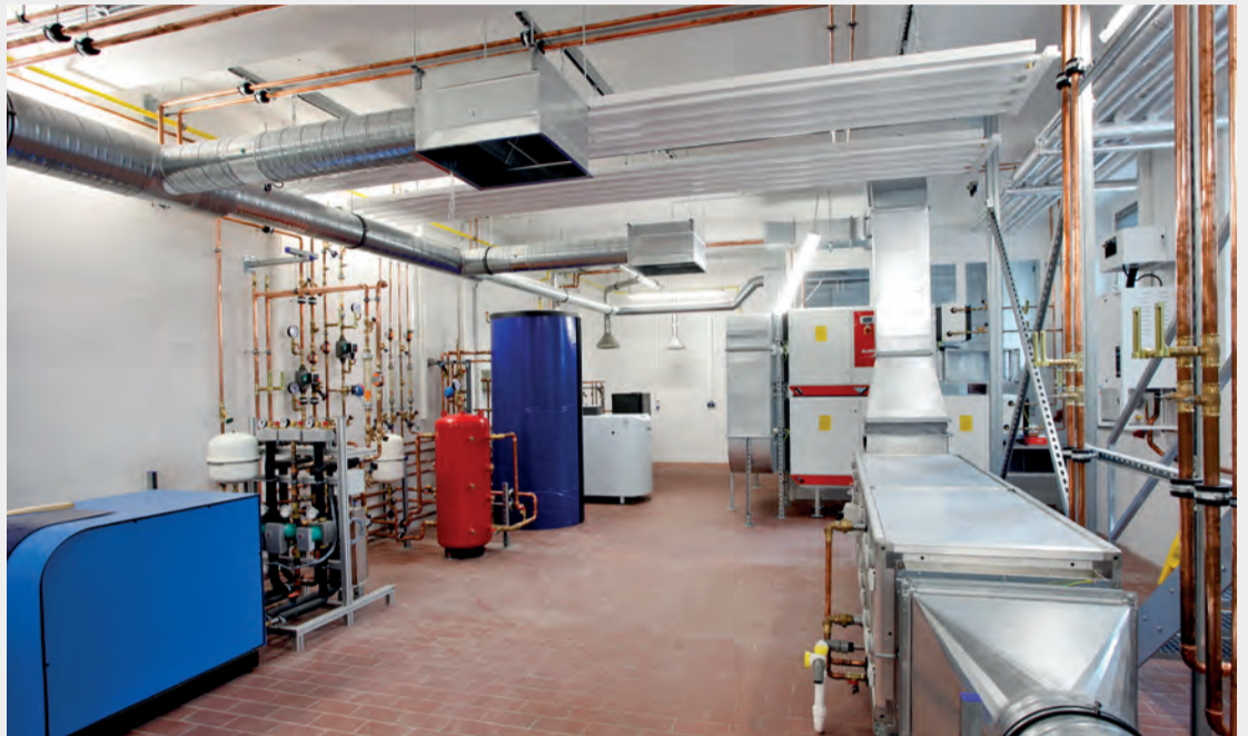
Neu eingerichtetes Labor des Studienganges „Gebäudetechnik“
