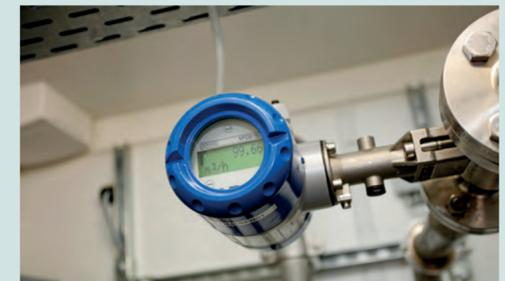
Volumenstrommessung der Abluft
