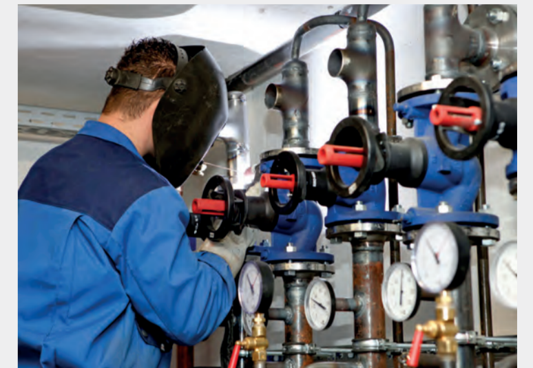
Monteur Mark Drenkelfuß beim Verteileraufbau
