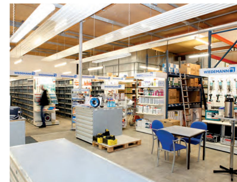
Neues Abhollager mit Deckenstrahlheizung
