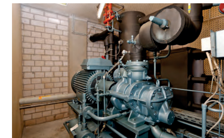
Kälteaggregat zur Versorgung des Mischbetriebs
