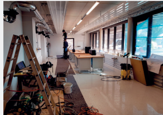
Innenausbau „Heinrichs Werkstatt“
