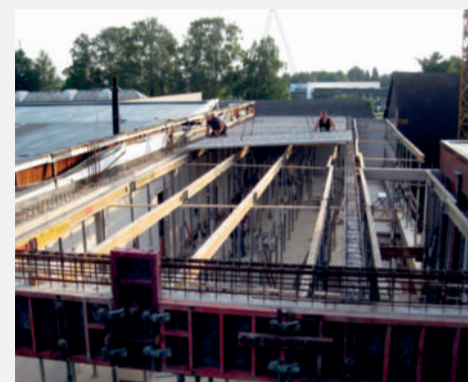
Rohbau „Heinrichs Werkstatt“
