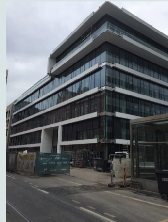
Gebäudefassade der Kasernenstraße kurz vor der Fertigstellung
